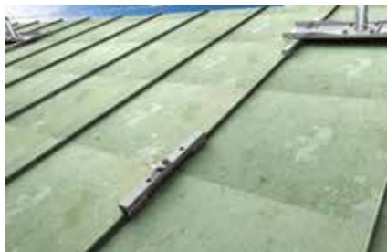
Messa in sicurezza copertura lamiera aggraffata
