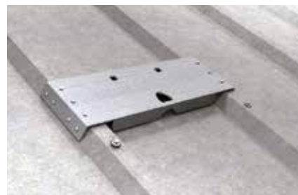
Dettaglio: fissaggio dell'ancoraggio puntuale PC A
