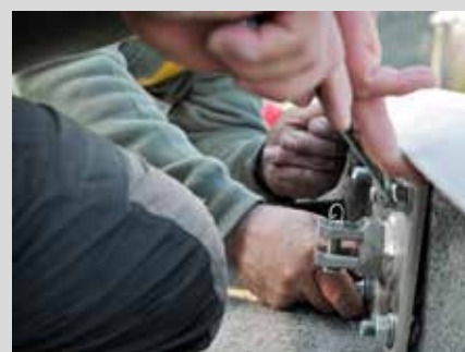
Fissaggio di piastra verticale intermedia
